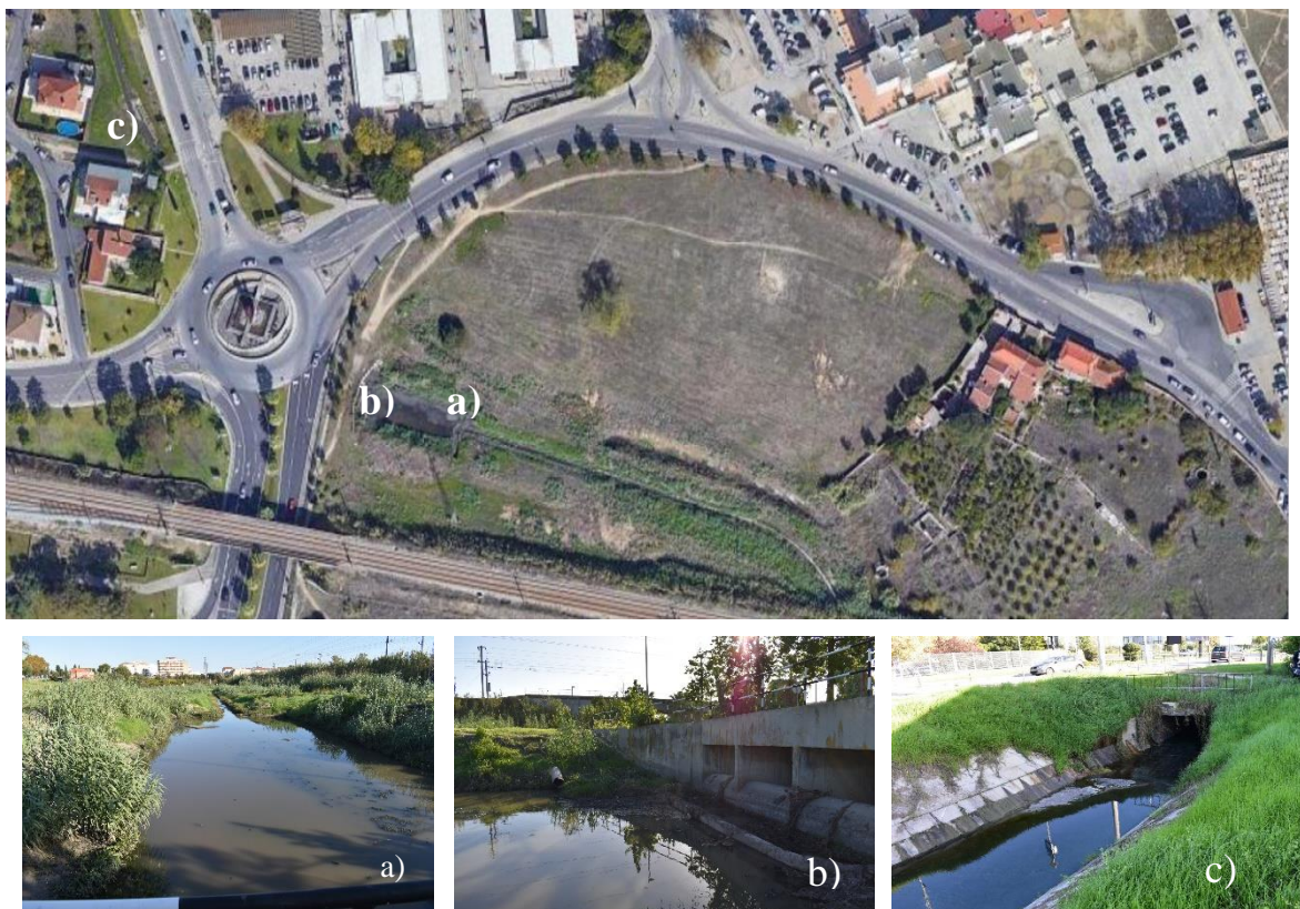
Figura 2. Bacia de drenagem (a) vista geral, (b) órgão descarregador, (c) vala a jusante
